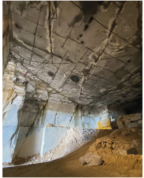
Cava in galleria.
